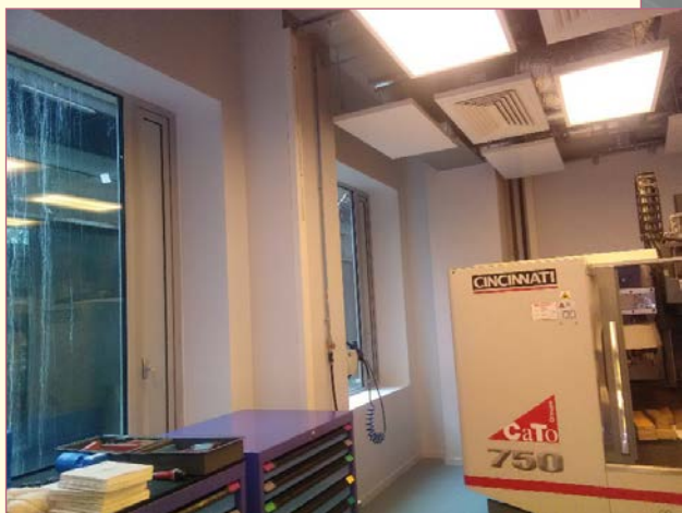
Atelier mécanique après réfection.
