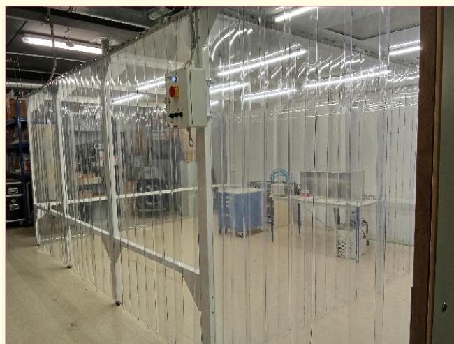
Le nouveau plafond soufflant en service.
