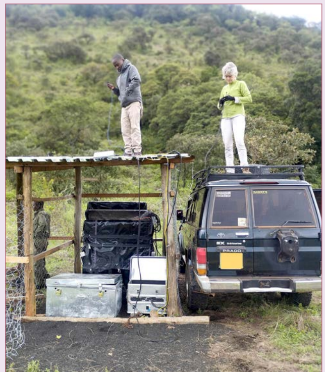
Opération de maintenance de l'alimentation électrique d'un détecteur de muons installé dans la chaîne des Chyulu au Kenya afin d'observer les variations saisonnières de son contenu en eau.
