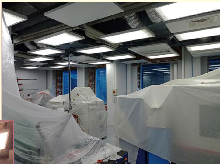
Atelier mécanique bâché en prévision des travaux.
