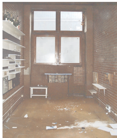
Figure 1 : vue d'un des bureaux de l'aile 32-42 avant rénovation.
