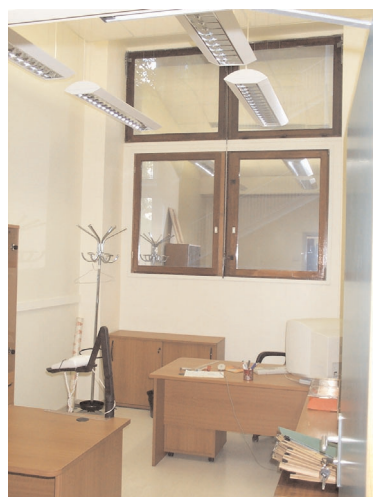
Figure 2 : vue d'un des bureaux de l'aile 32-42 après rénovation.
